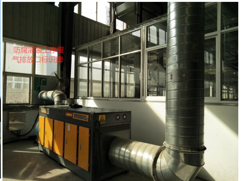
附图6 防腐灌装工序光催化氧化装置、排气筒和标识牌
