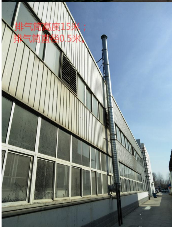
附图6 防腐灌装工序光催化氧化装置、排气筒和标识牌
