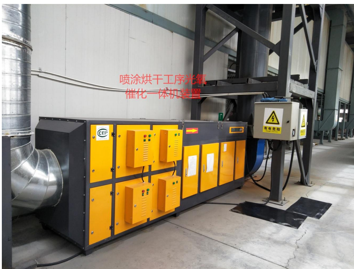
附图 8 喷涂烘干工序光氧催化一体机装置、排气筒和标示牌
