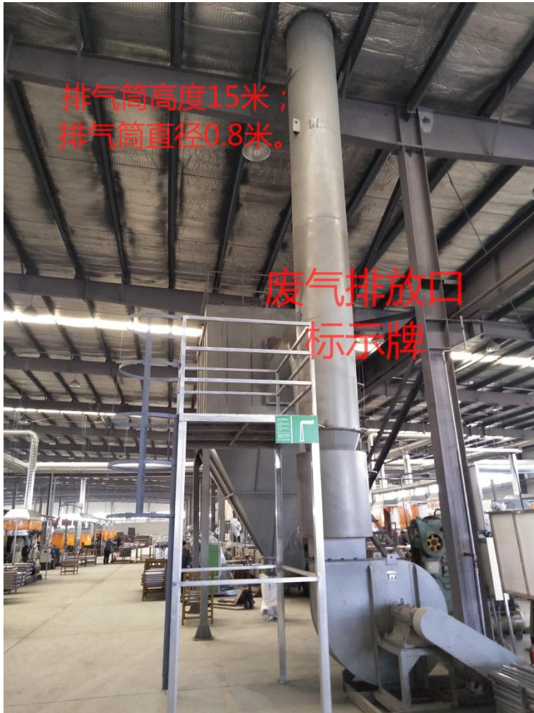
附图3 打磨抛光工序处理设施、排气筒和标示牌
